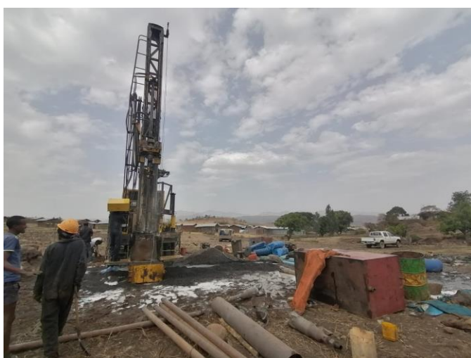
Creusement du forage
