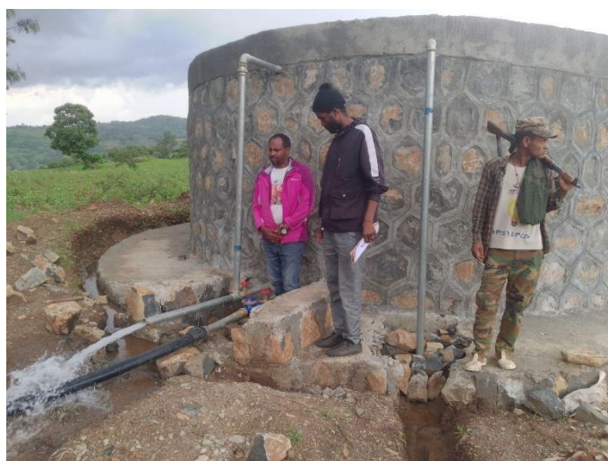
Réservoir de 75m 3 en fonctionnement
