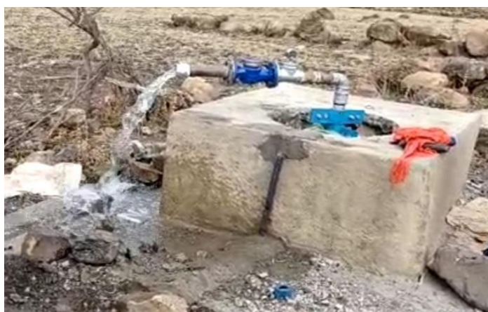
Lancement du forage
