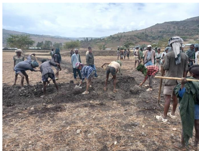
Creusement des tranchées par les villageois
