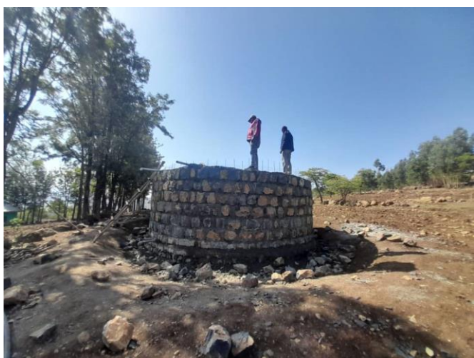
Le réservoir en cours de finition
