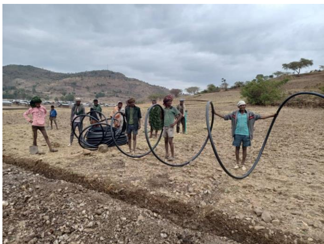
Installation des canalisations de desserte par les villageois
