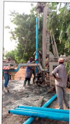
FORAGE. GOUTTE À GOUTTE (CAMEROUN)
